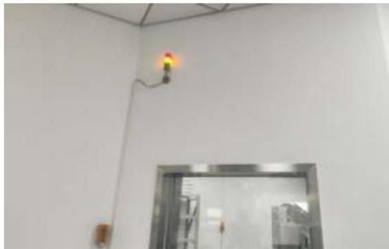
图 3-5 本项目声光报警装置现场照片
