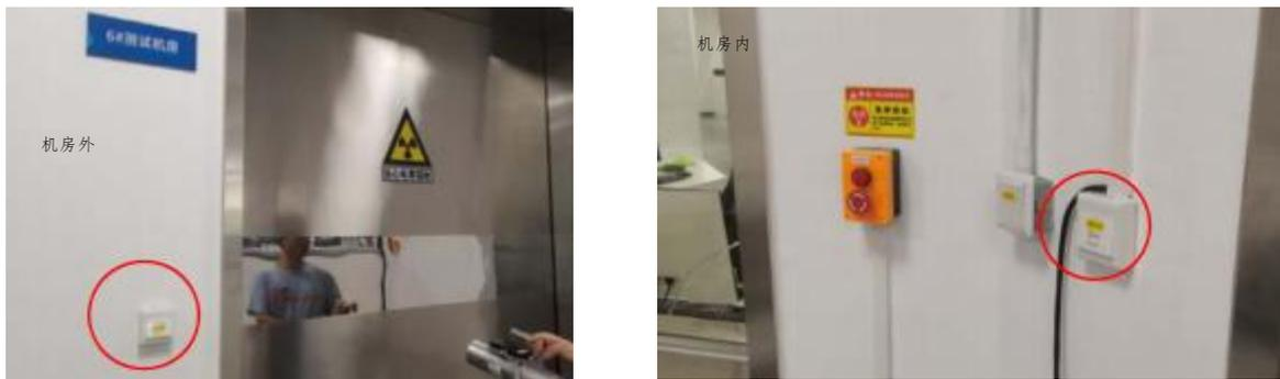
图 3-8 本项目紧急开门按钮现场照片（部分）
