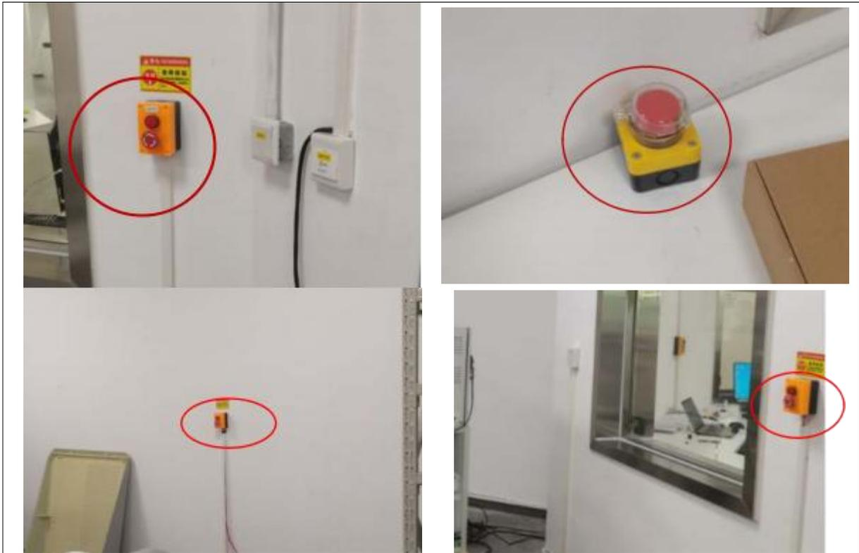
图 3-6 本项目急停开关现场照片（部分）
